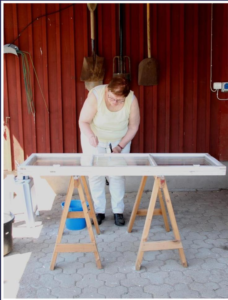
Ein Vedboden-Fenster in Bearbeitung: Abschleifen, Kit ausbessern, reinigen, streichen, defekte Arretierung auswechseln.
